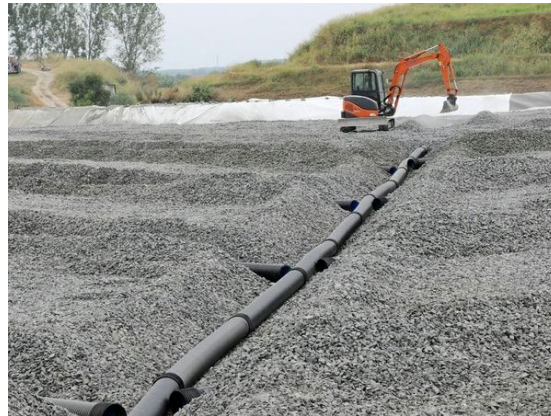
Torretta di Legnago dumpsite works, Italy
