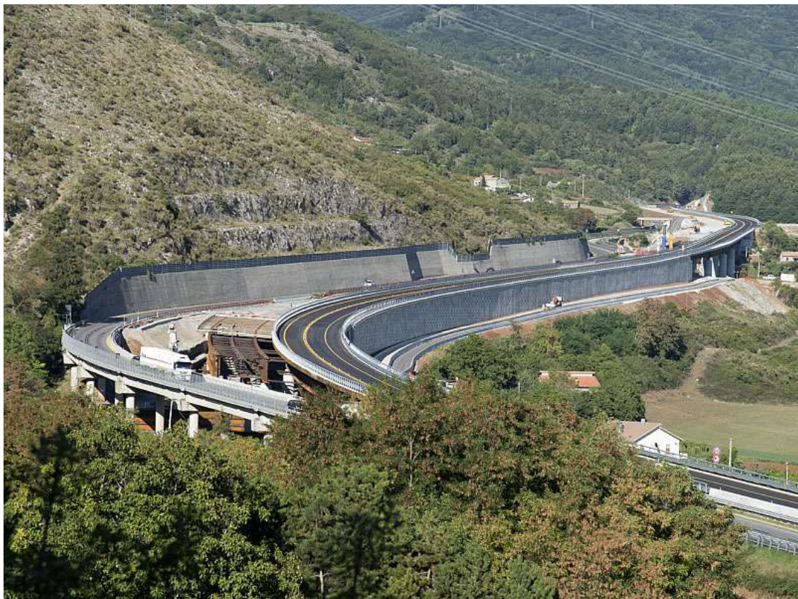
Viaduct Mancuso - L= 253 m
